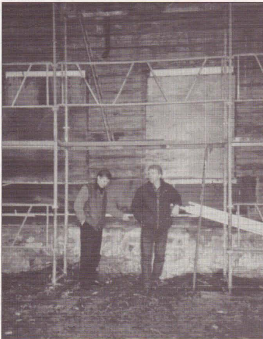
Jon Martin Trollaldalen og Asgeir Føyen kontrollerer rehabiliteringsarbeidet på Abildsø gård.
