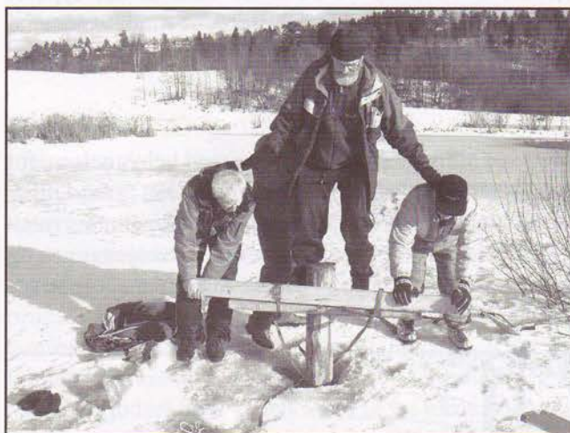
Stauren skrus ned i bunnen. Finn Tshudi er «lodd», mens han blir støttet av Odd Frode Ulbrandt (skjult bak Finn). Johan Mollatt og Hans Englund dreier boret rundt.
