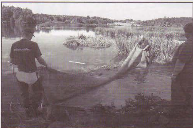
Bunnen i det oppdemmede området ble dekket med kokosmatter før jord ble tilkjørt. Friluftsetatens folk i arbeid.
