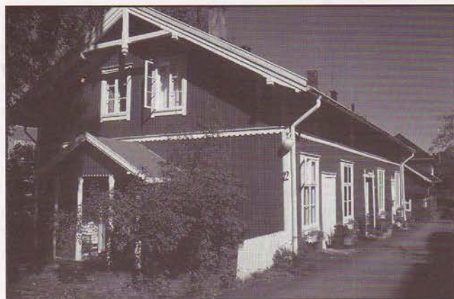
Ester Johnsen kom til verden i arbeiderboligen fra 1886, Harry Fetts vei 2, tidligere Østensjøveien 93.
