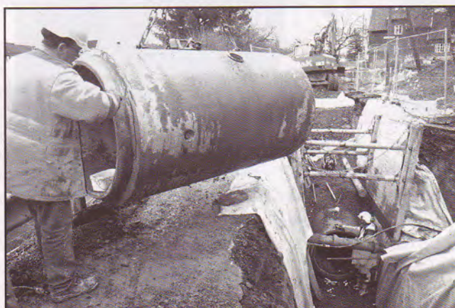
Rør med en diameter på 1000 mm ble manøvrert ned i grøften med stor presisjon
