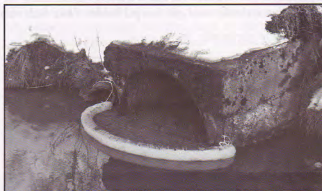
Lense og bark var middel til å hindre ytterligere forurensning av Bogerudmyra og Østensjøvannet.
