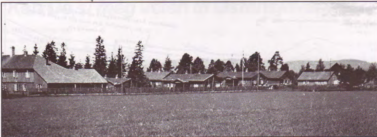
På bildet ser vi Rosenbusch-leiren fra øst mot vest. Til venstre skimter vi den store kontorbygningen i to etasjer med valmet tak. Den stod her til rett før blokkene langs Haakon Tveters vei ble reist tidlig på 1950-tallet. De andre bygningene er forlegninger.
