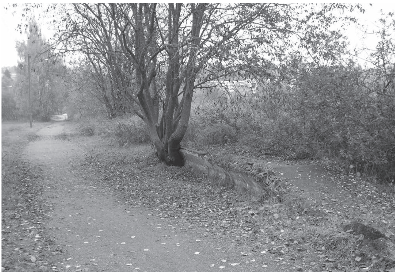
Rampelignende konstruksjon nord for Vadedammen.
