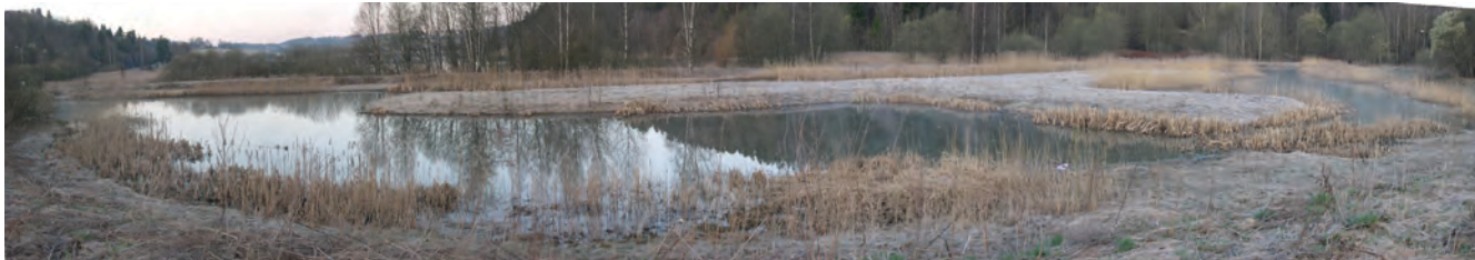
Vadedammen, før rehabiliteringen.
