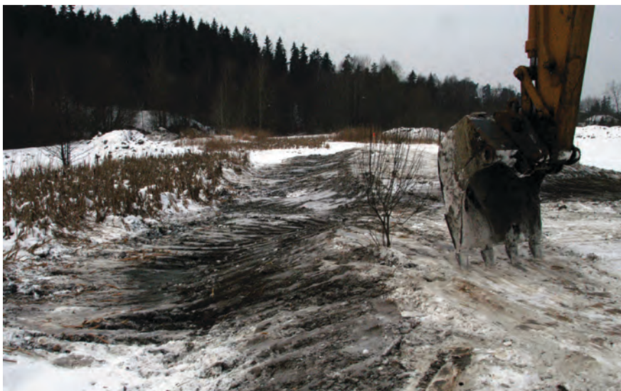
Med nennsom hånd er en gravemaskin et flott verktøy som kan lage de mest delikate bunnprofiler. Det hjalp at bunnen var stivfrossen leire som var lett å forme.
