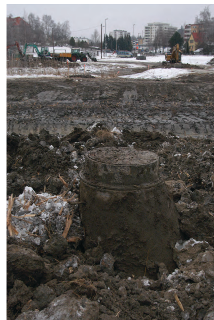
Eksisterende kummer blir undersøkt og oppgradert til de nye masseprofilene i terrenget.
