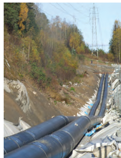
Midtveis i oktober var rørledningene fremført til Bakkeløkka.
