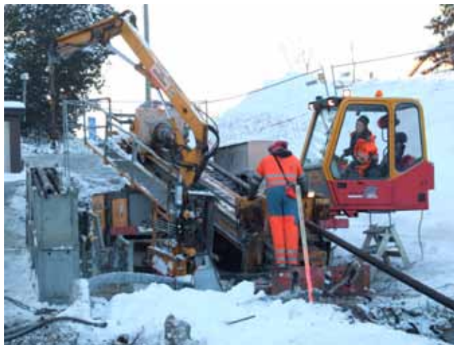
Boremaskinen på vestsiden av kanalen trekker røret gjennom leire- og torvmassene.
