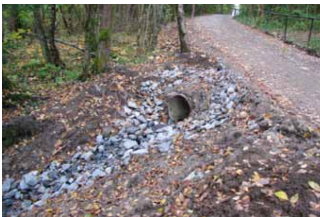
Manglerudbekken kommer her ut av et rør under turveien. Rørene ligger over høyspentkablene forberedt for anlegg av bro over bekken når gjenåpning en gang kan finne sted.
