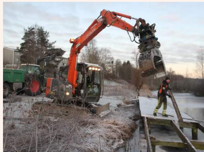
Brygga rives 20. desember 2011. Det er folk fra entreprenør Torstein Skjaker som utførte jobben for Bymiljøetaten.
