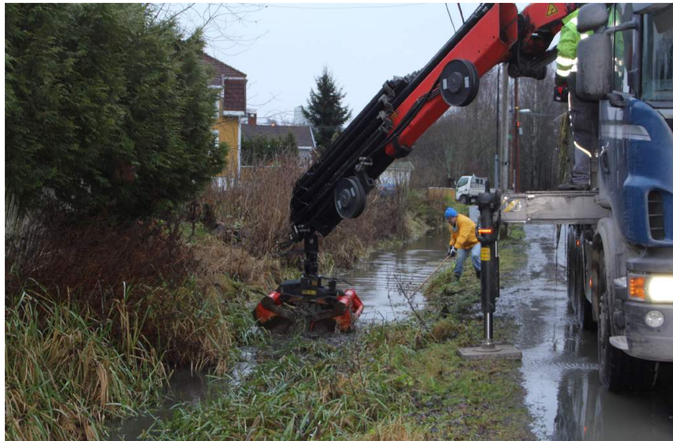
Entreprenør Bjørn Løvold gjorde en god opprenskningsjobb i Østensjøbekken langs Granhekkveien. Foto 21. november 2011.
