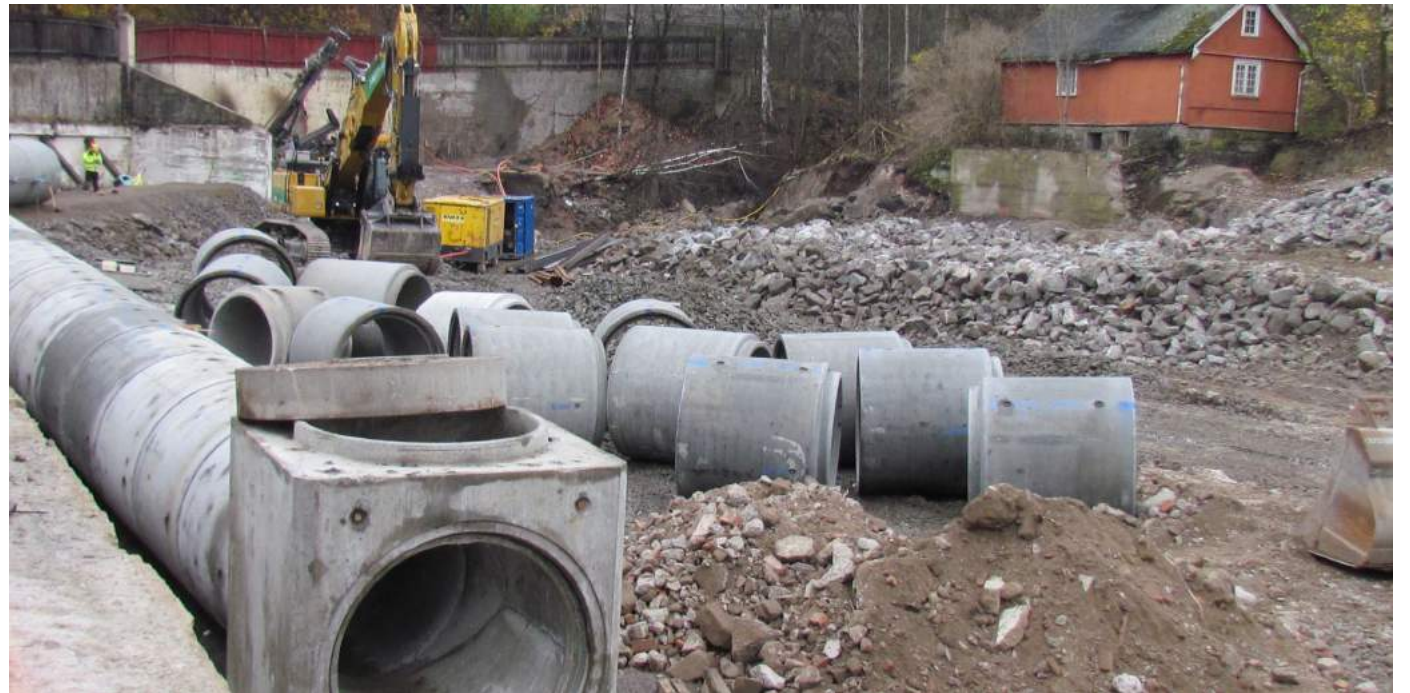
Kulverten er ca. 2 meter i diameter. Den ligger delvis oppå den gamle og følger Østensjøveien rundt svingen. Østensjøveien ble lagt om i 1870-årene og fulgte bekkens slyng. Veien er senere bygget opp. Mot Bryn senter er kulverten koblet til den gamle kulverten under Harry Fettes vei. For å bedre utløpskapasiteten fra Østensjøvannet ble det i midt på 1960-tallet bygget en tunnel som møter Østensjøbekken omtrent under senterets parkeringsplass. Bildet er tatt 3. november 2011.
