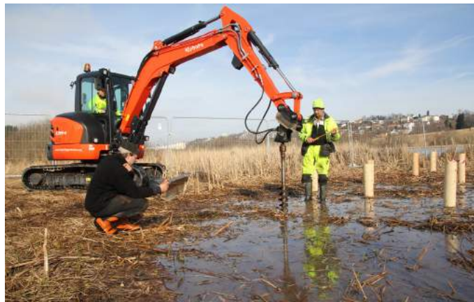
Med en liten gravemaskin ble det boret hull for de ca. 40 malmfurstokkene som var nødvendig for et stabilt underlag. Korrekte mål var viktig slik at stokkene skulle stå loddrett. Malmfurstokkene ble presset ned ca. 6 m med grabben på en større gravemaskin.
