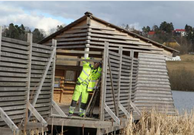
Folk fra ICC, Bymiljøetatens entreprenør, fikk raskt utbedret skaden ved å slå på nye bord. Foto: Leif-Dan Birkemoe.
