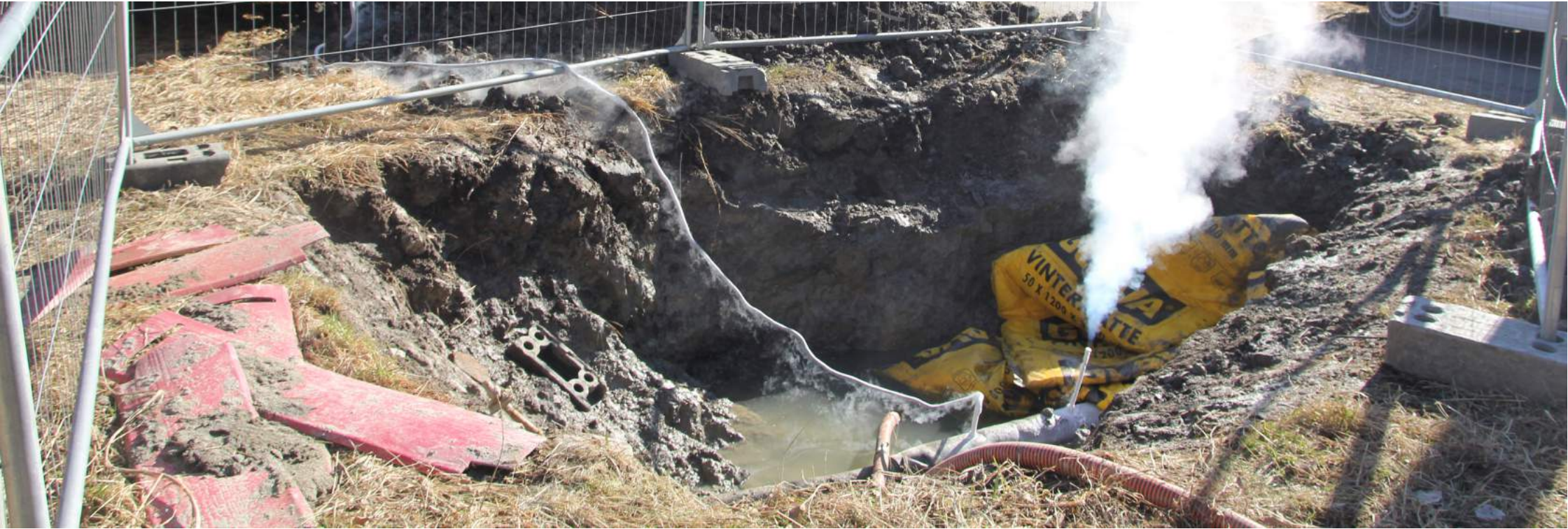
Flytende nitrogen brukes for å fryse kablen i et forsøk på å lokalisere bruddet. Her føres nitrogen i slange fra en beholder til kablen i bakken. Skyen som står opp fra grøften skyldes at flytende nitrogen holder minus 210 grader C. Mannen på tilhengeren regulerer beholderen med nitrogen.
