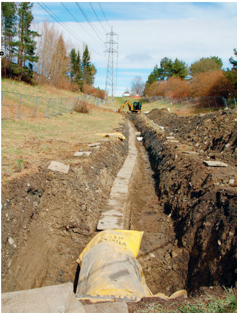
Fra trafoen i Plogveien graves det nordover i kraftgaten vest for Plogveien og videre østover nord for Manglerud skole.
