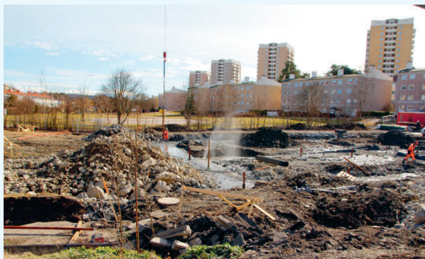
I mars var det forholdsvis store grunnarbeider på gang ved Byggveiens laveste punkt. I dalen går en tilførselsbekk til Smedbergbekken som igjen renner ut i Østensjøvannet. Foto: Leif-Dan Birkemoe, 24.03.2015.
