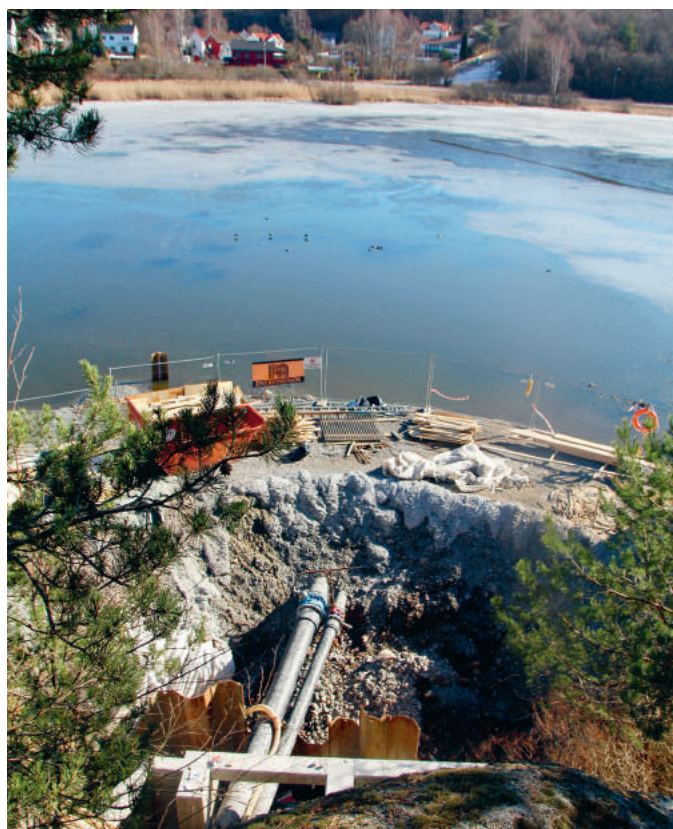
Det ble bygget en ytre fangdam i vannet rundt området. Dette var nødvendig fordi støpning av ny dam måtte skje tørt. Vannstanden ble regulert med uttapping av vann gjennom rørene. Foto: Leif-Dan Birkemoe 14.03.2015.
