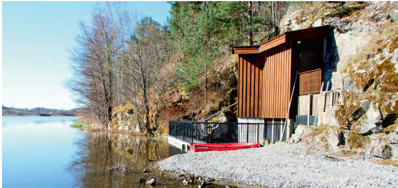
Damhuset med damluken i vannets nordvestre hjørne tar unna vannmassene gjennom en utsprengt tunnel. Enkel adkomst til damhuset er tilrettelagt for Vann- og avløpsetatens inspektører. Foto: 23.04.2016.
