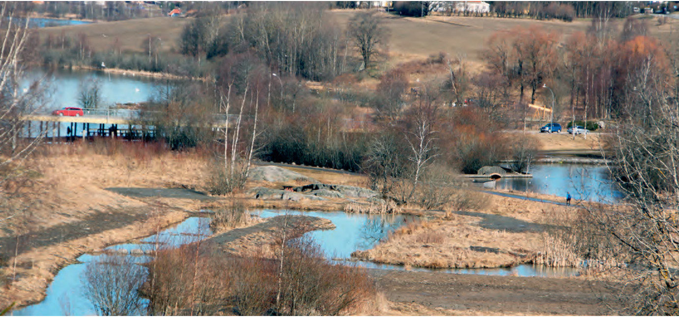
Langerudbekken ble bygd som rensepark i 2005. Rehabiliteringen ble ferdig i slutten av mars 2016. Sedimenter er fjernet og tersklene forsterket. Renseeffekten skal nå være mye bedre. Det mørke feltet nederst til høyre på bildet er en ny grunn flomdam. Vannet fra første rensedam renner over og inn i flomdammen ved stor vannføring. Foto 01.04.2016.
