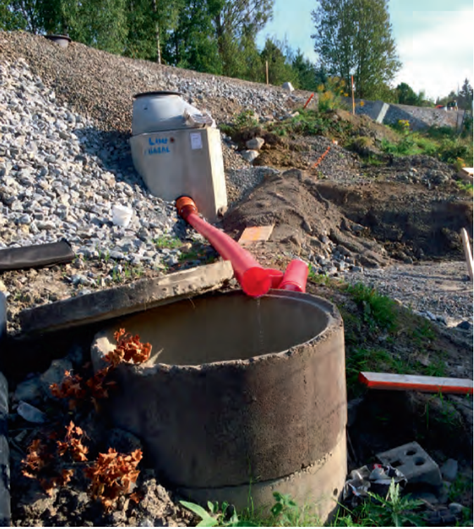
Overvann på strekningen Godlia - Skøyenåsen er samlet opp og føres i midlertidig rør fra banetraseen til kommunens overvannsledning. Foto: Leif-Dan Birkemoe, 09.09.2015.
