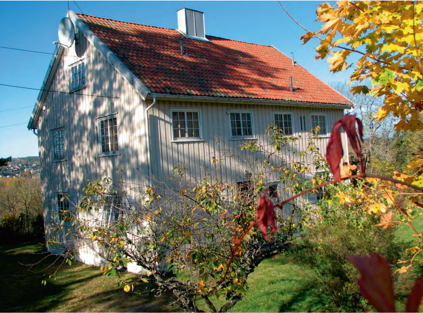
Disponentboligen til Eterfabrikken foreslås revet. Foto: 07.10.2007.
