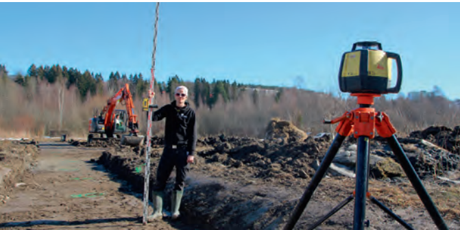
Flomdammen utformes. Staven for lasermåling holdes av Ole Jonny Delerud og i gravemaskinen Håkon Svarstad, begge fra Anleggsgartnermester Løvold AS. Foto 15.03.2016.
