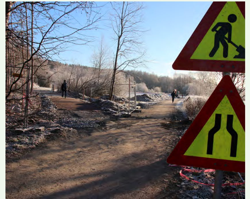
Den nye veien ble anlagt i oktober/november. Til høyre den gamle veien som blir ført tilbake til fukteng. Foto: Leif-Dan Birkemoe, 26.11.2018.
