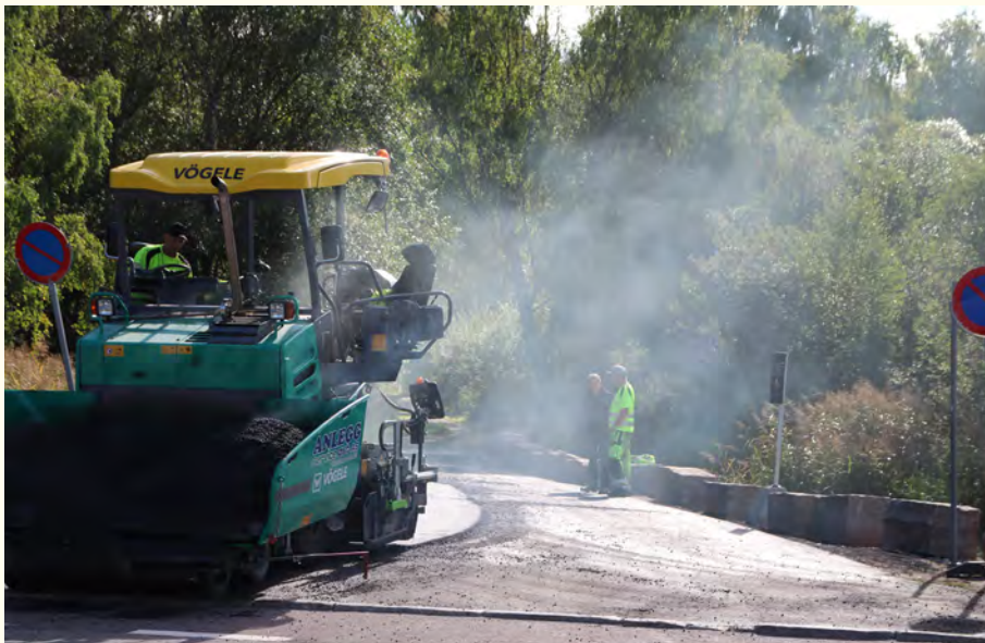
Asfalteringsmaskiner og veivalser i gang med å legge asfalt. Foto 21.08.2018.
