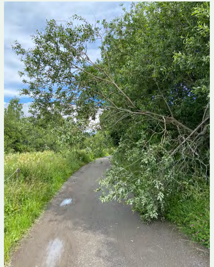
Treet lå delvis over veien og var i ferd med å falle helt ned. «Bymelding» ble sendt og treet fjernet. Foto: Leif-Dan Birkemoe, 07.07.2020.
