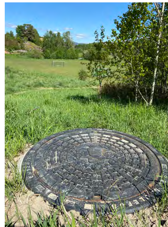
Kumlokket i «Fjøsli», godt synlig i skråningen over Merkantiltfeltet opp mot Bakkehavn. Ulefoss Jernverk AS har produsert lokket. Foto: 29. mai 2020.
