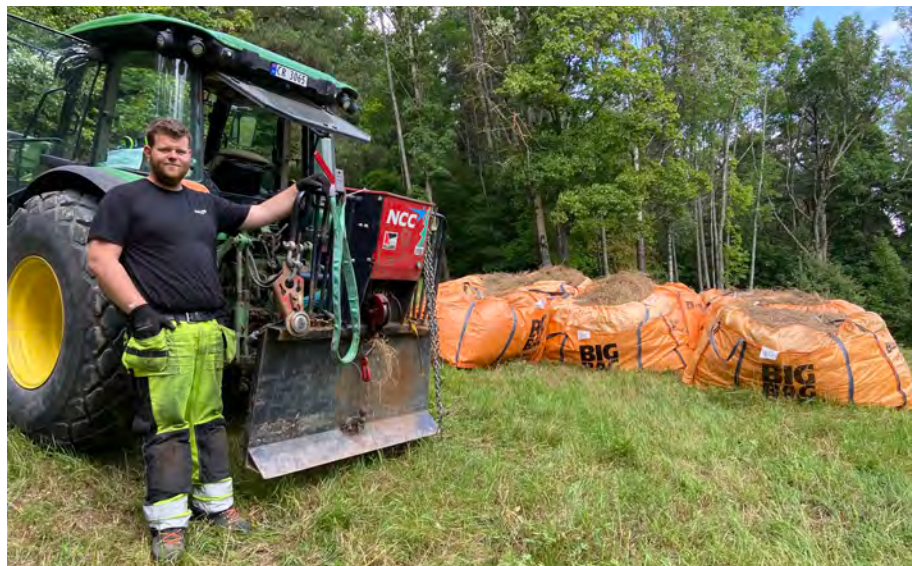
Gresset er lagt i sekker som trekkes inn med wire fra traktor. Det var Håvard fra Bymiljøetatens entreprenør NCC som utførte jobben, 19.08.2020.
