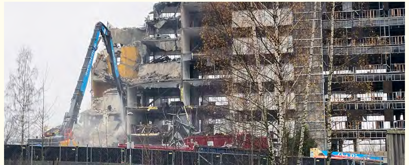
Oppsal sykehjem under nedrivning. Foto: Leif-Dan Birkemoe, 10.11.2020.
