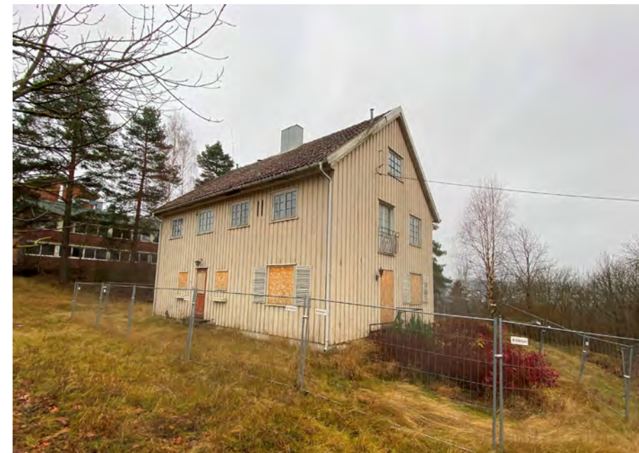
Disponentboligen er inngjerdet og vinduene i første etasje har fått lemmer. Foto: Leif-Dan Birkemoe, 11.11.2020.
