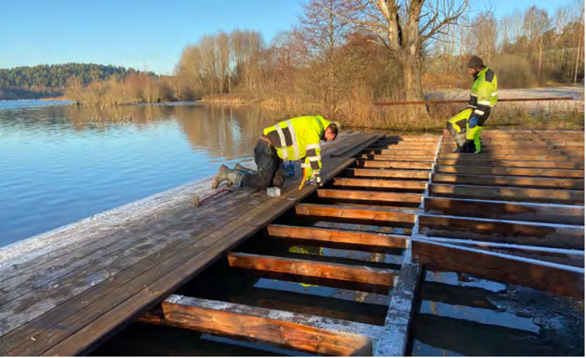
Ved Bølebekkens utløp er det under bygging en platting som et fint utsiktspunkt. Foto: Leif-Dan Birkemoe, 26.11.2020. (Se side 13).
