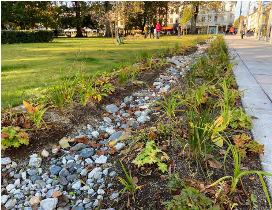
Regnbeddet ved Olaf Ryes plass fremstår som en beplantet forsenking i terrenget, nærmest som en bekketrase der vann renner på overflaten og ned i et magasin eller basseng på 200 m 3 anlagt under gresset. Når det ikke regner, er det tørt. Foto: Leif-Dan Birkemoe, 15.10.2020.
