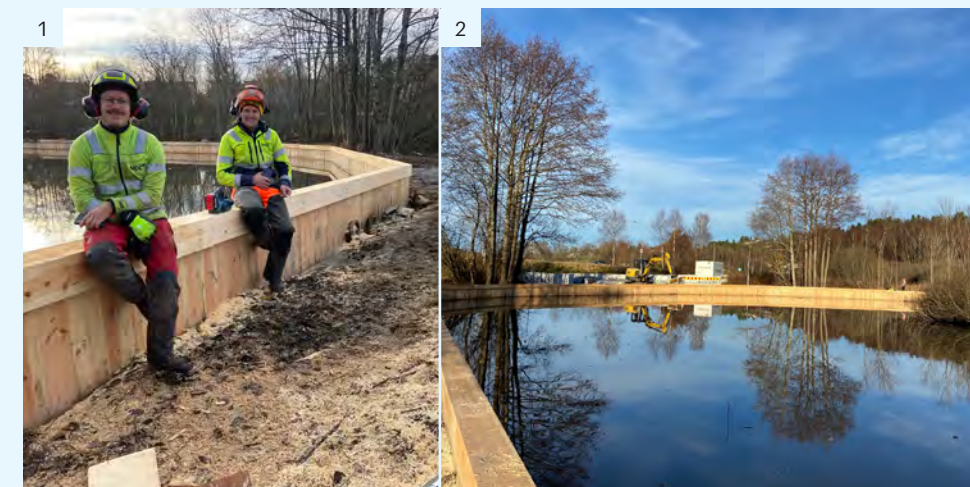
1) Fra venstre Lars og Mantas hos NCC som har stått for spuntingen forteller at varierende grunnforhold bestemmer hvor langt bordene kan bankes ned. Gjennomsnittet anslø de til ca. to meter. Foto: Leif-Dan Birkemoe, 06.11.2020. 2) Den rehabiliterte spuntveggen fremstår som en solid mur i dammen ved overgangen mellom Bogerudmyra og Østensjøvannet. Foto: Leif-Dan Birkemoe, 05.11.2020.
