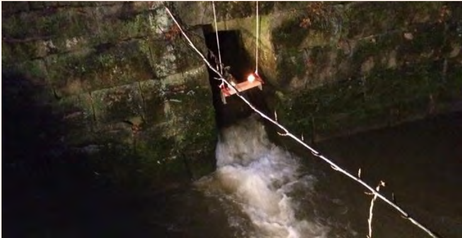
Bekkeutløpet flombelyses og det heises ned fakler for å vise hvor vannet kommer ut av kulverten. Foto: Leif-Dan Birkemoe.
