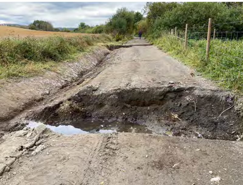
Grunnarbeidet besto først i å lage stikkrenner på tvers av veien langs Bekkasinmyra.
