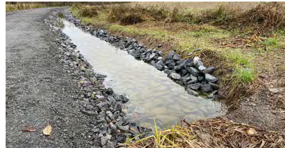
Renoveringen besto bl.a. i å lage dype grøfter som vannet fra jordet og veioverflaten kunne renne ned i, for så å bli drenert ut på Bekkasinmyra. I noen tilfeller ledes vannet direkte ut til Østensjøvannet gjennom stikkrenner.
