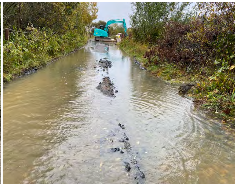
Regnet gjorde plutselig veien ufremkommelig. Gravemaskinen måtte i en periode parkere.
