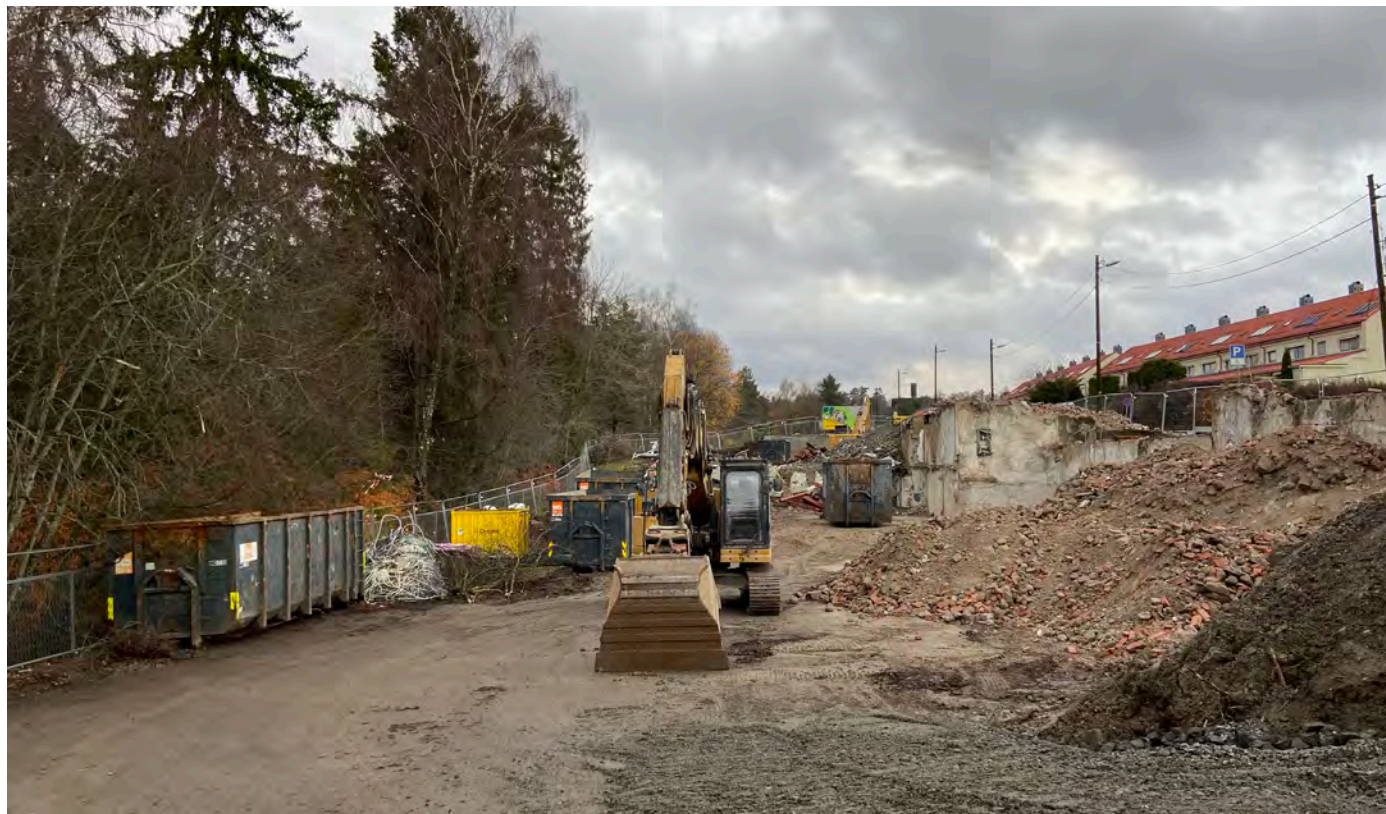
Det lave institusjonshuset i Bogerudveien 15 er revet og skal erstattes av boligblokker rett i skogkanten. Foto: Leif-Dan Birkemoe, 04.11.2022.
